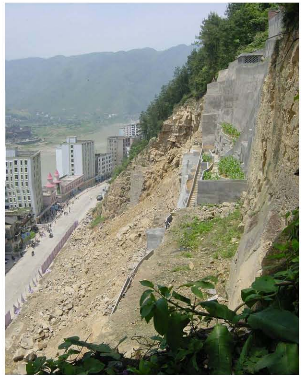
重庆武隆城西崩塌。体积 1.7 万立方米，9 层楼被埋，死 79 人（2001）
